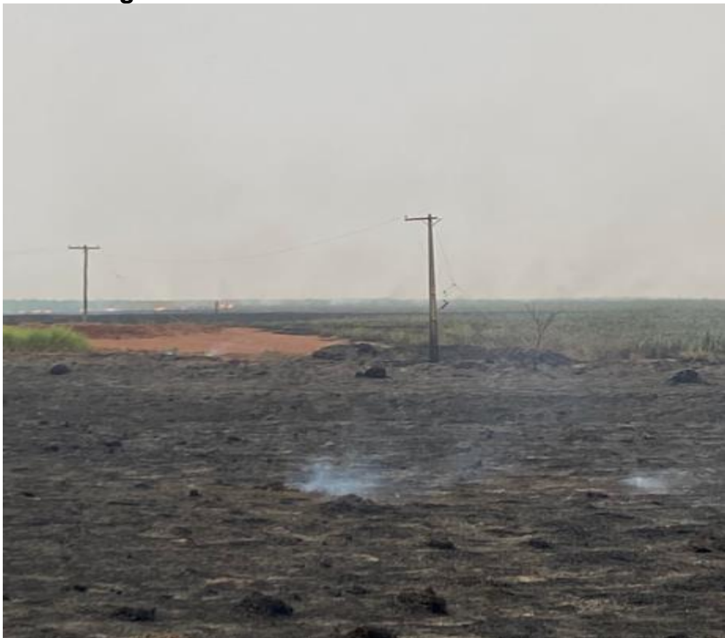
Figura 13 – Foto da ocorrência 2024- 1127674
