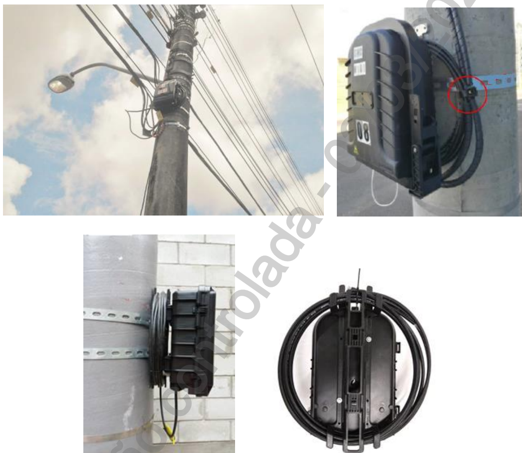
Figura 5 – Exemplos de Caixa CTO/NAP com Cabo de Descida Acomodado Atrás da Caixa
