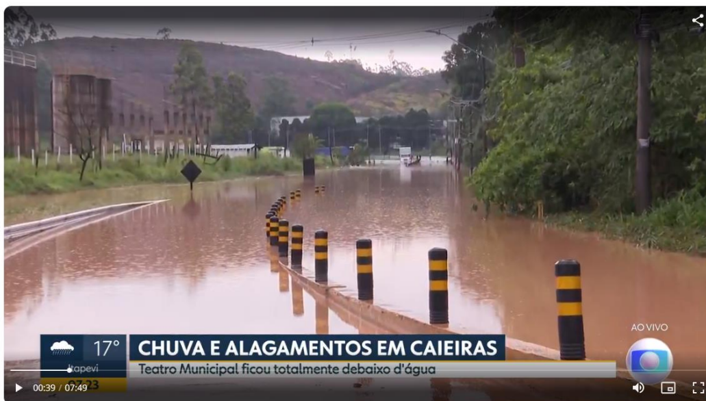
Chuva alaga teatro municipal e fecha principal acesso à Caieiras
