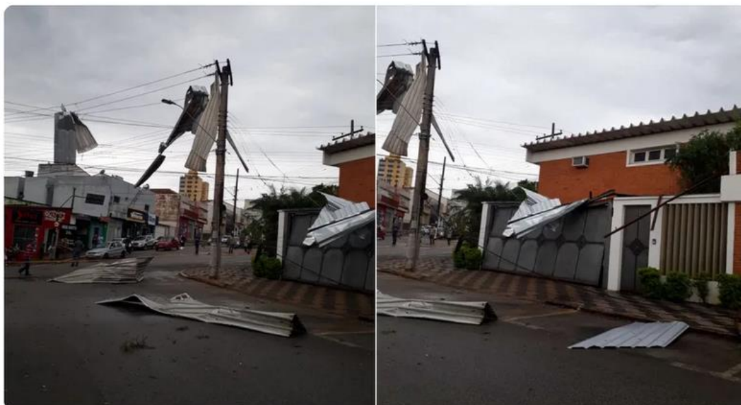
Parte do telhado de um estabelecimento foi arrancado com a força do vento, em Itapeva (SP) — Foto: Arquivo pessoal
