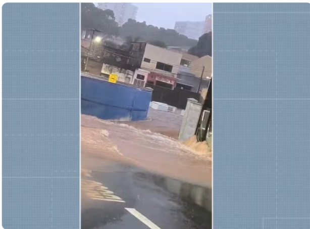
Tempestade faz piscinões transbordarem e causa prejuízo a comerciantes no centro de Limeira — Foto: Reprodução/EPTV
