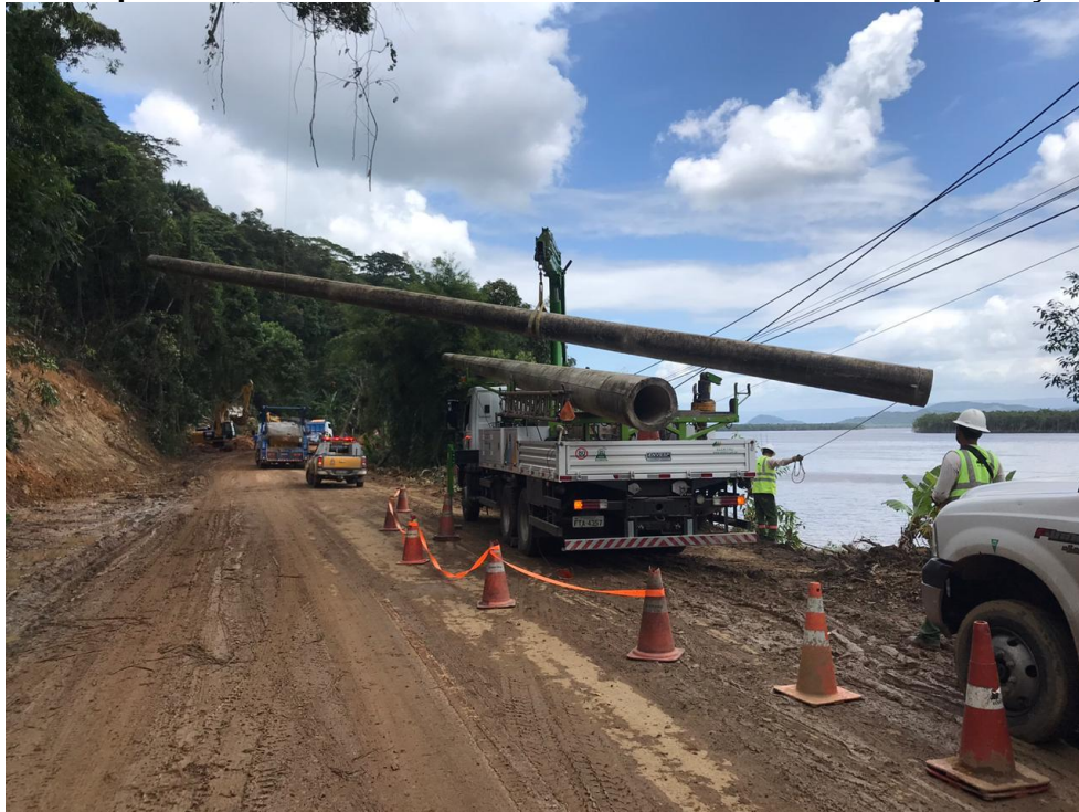
Figura 19 – Rede provisória sobre rio devido estrada intransitável
