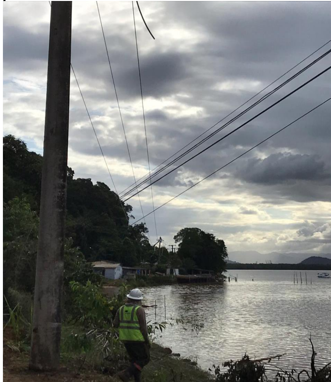
Figura 21 – Rede provisória sobre rio devido estrada intransitável – Concluído
