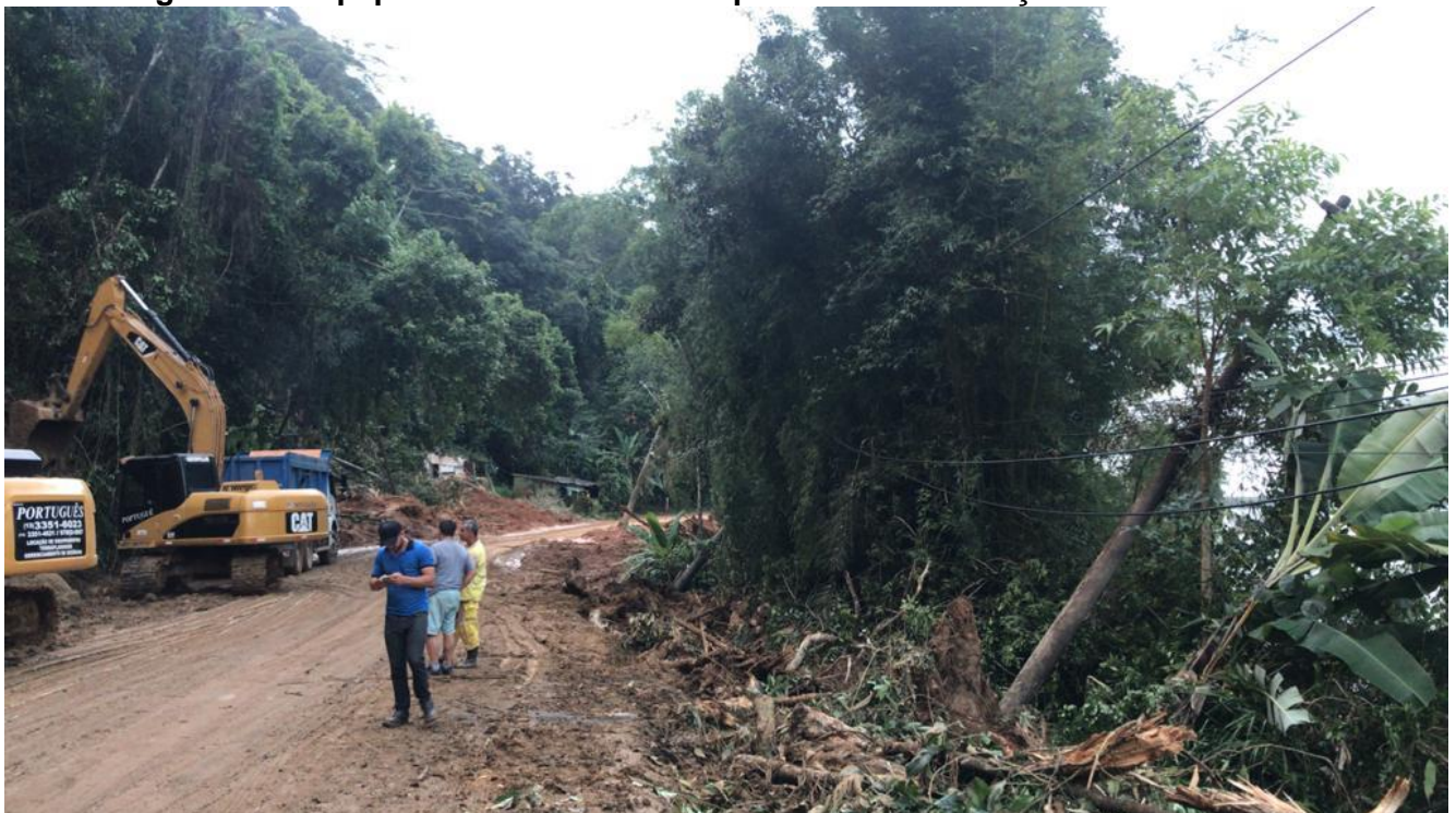
Figura 12 – Equipes trabalhando na Limpeza e Reconstituição de Acessos
