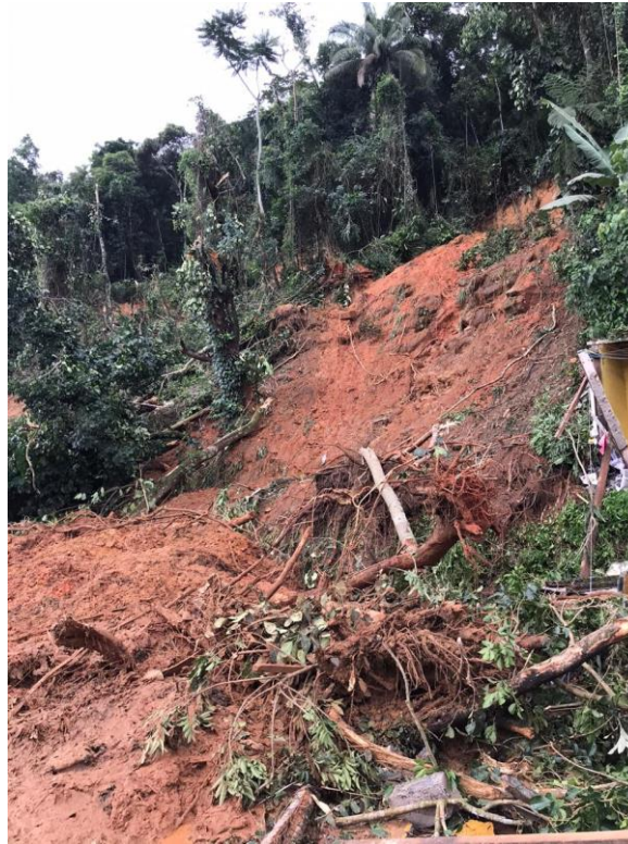
Figura 11 – Deslizamento de terra encosta no trecho do RL GUA00248
