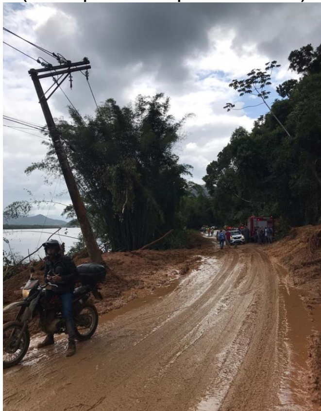
Figura 16 – Trecho da estrada após desimpedimento parcial pelo DER dia 04/03/2020 (Detalhe:poste flertido pelo deslizamento)
