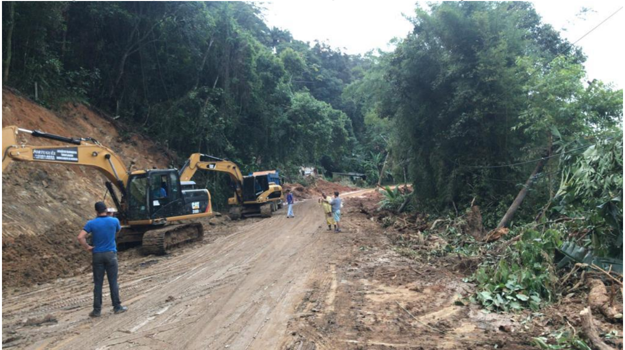
Figura 13 – Equipes trabalhando na Limpeza e Reconstituição de Acessos
