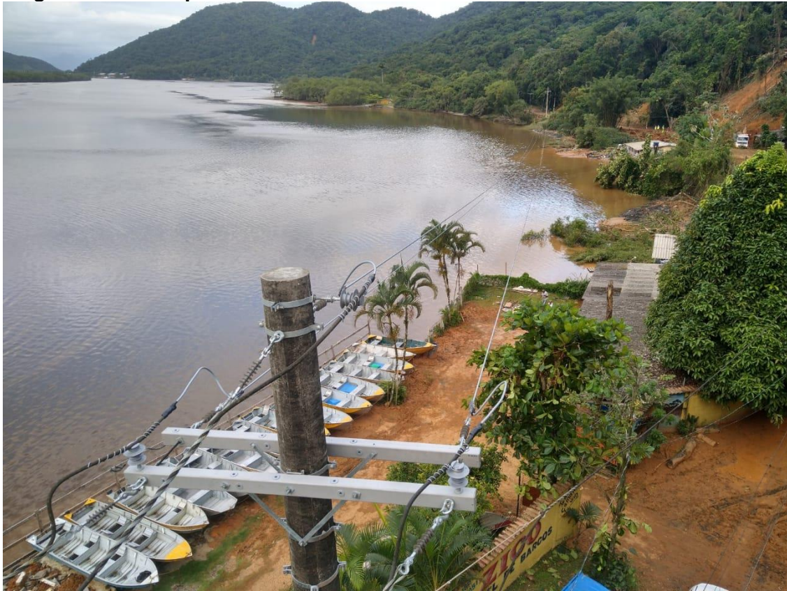
Figura 23 – Local onde a rede foi estendida sobre o rio com vão de aproximadamente 300 metros.
