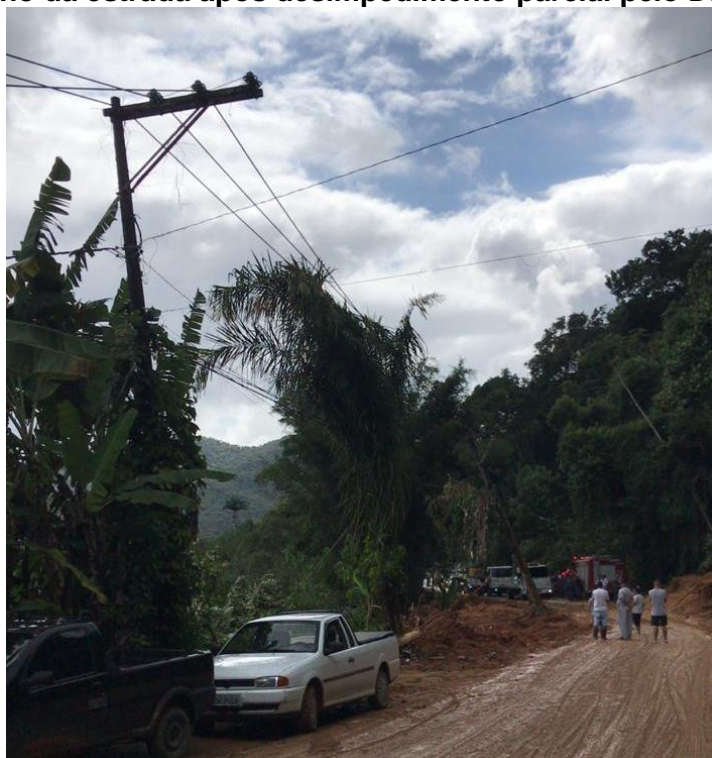
Figura 17 – Trecho da estrada após desimpedimento parcial pelo DER dia 04/03/2020
