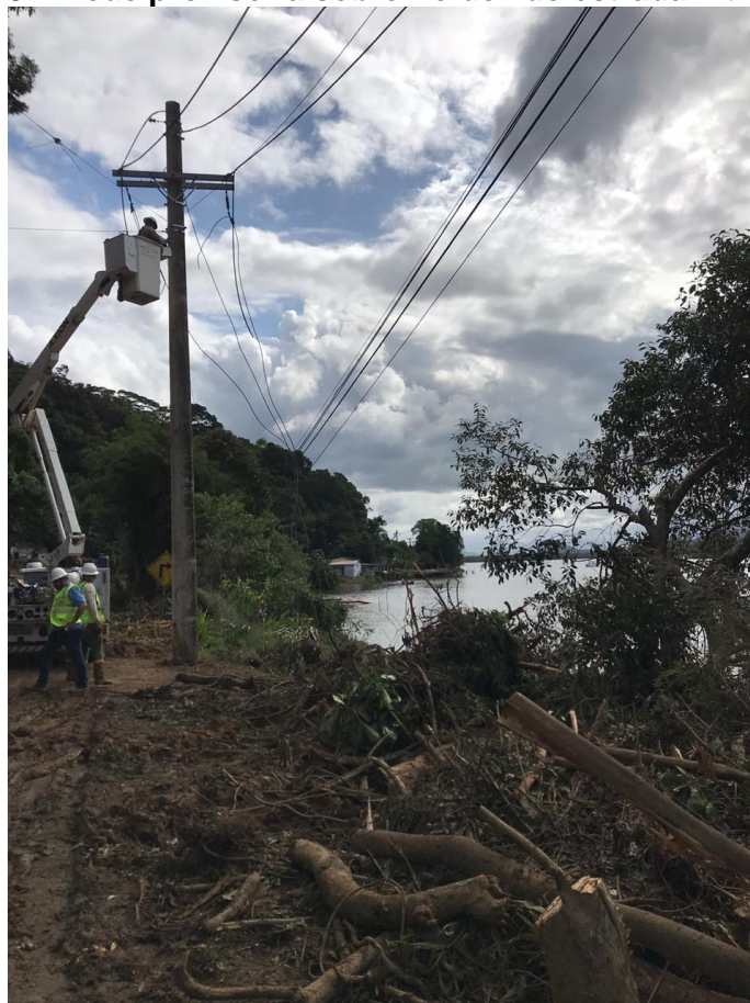
Figura 19 – Rede provisória sobre rio devido estrada intransitável
