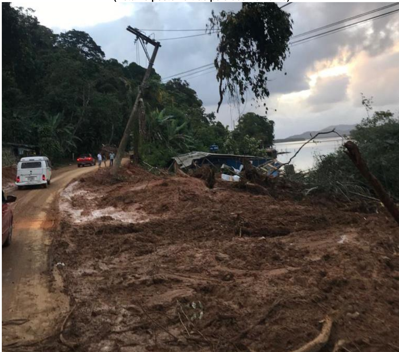
Figura 15 – Trecho da estrada após desimpedimento parcial pelo DER dia 04/03/2020 (Detalhe:poste flertido pelo deslizamento)
