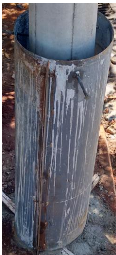
Fotos Ilustrativas – Forma para recuperação de poste
