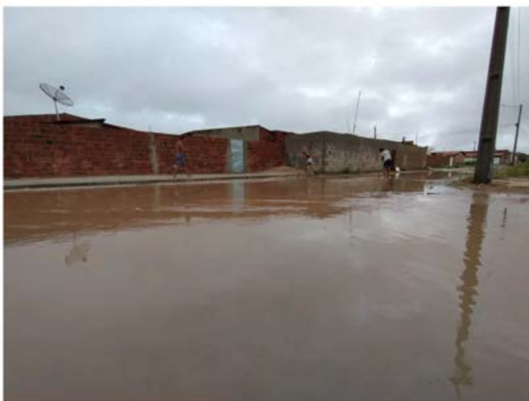
Bairro Fernando Idelino tem ruas alagadas após fortes chuvas — Foto: Emerson Rocha/g1
