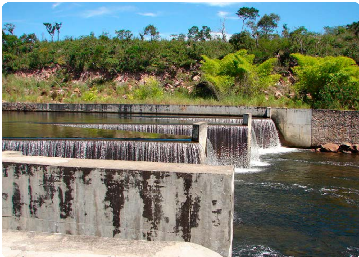
VISTA DA BARRAGEM DA PCH ALTO FÊMEAS - BA
