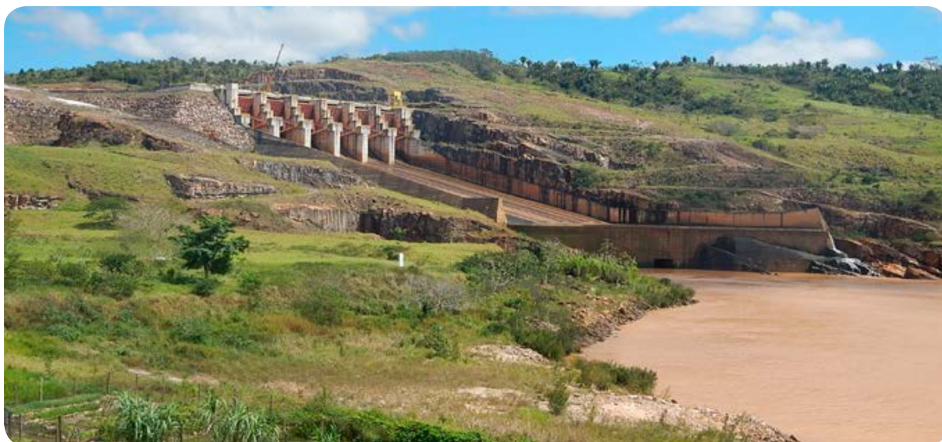
VISTA DA USINA HIDRELÉTRICA DE ITAPEBI
