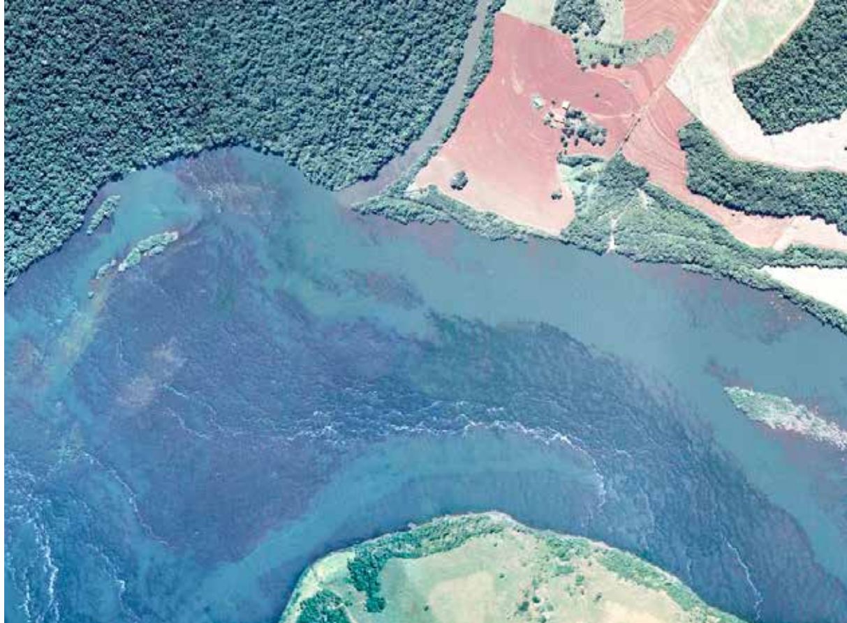
VISTA DO RIO IGUAÇU, ONDE ESTÁ SENDO CONSTRUÍDA A USINA BAIXO IGUAÇU
