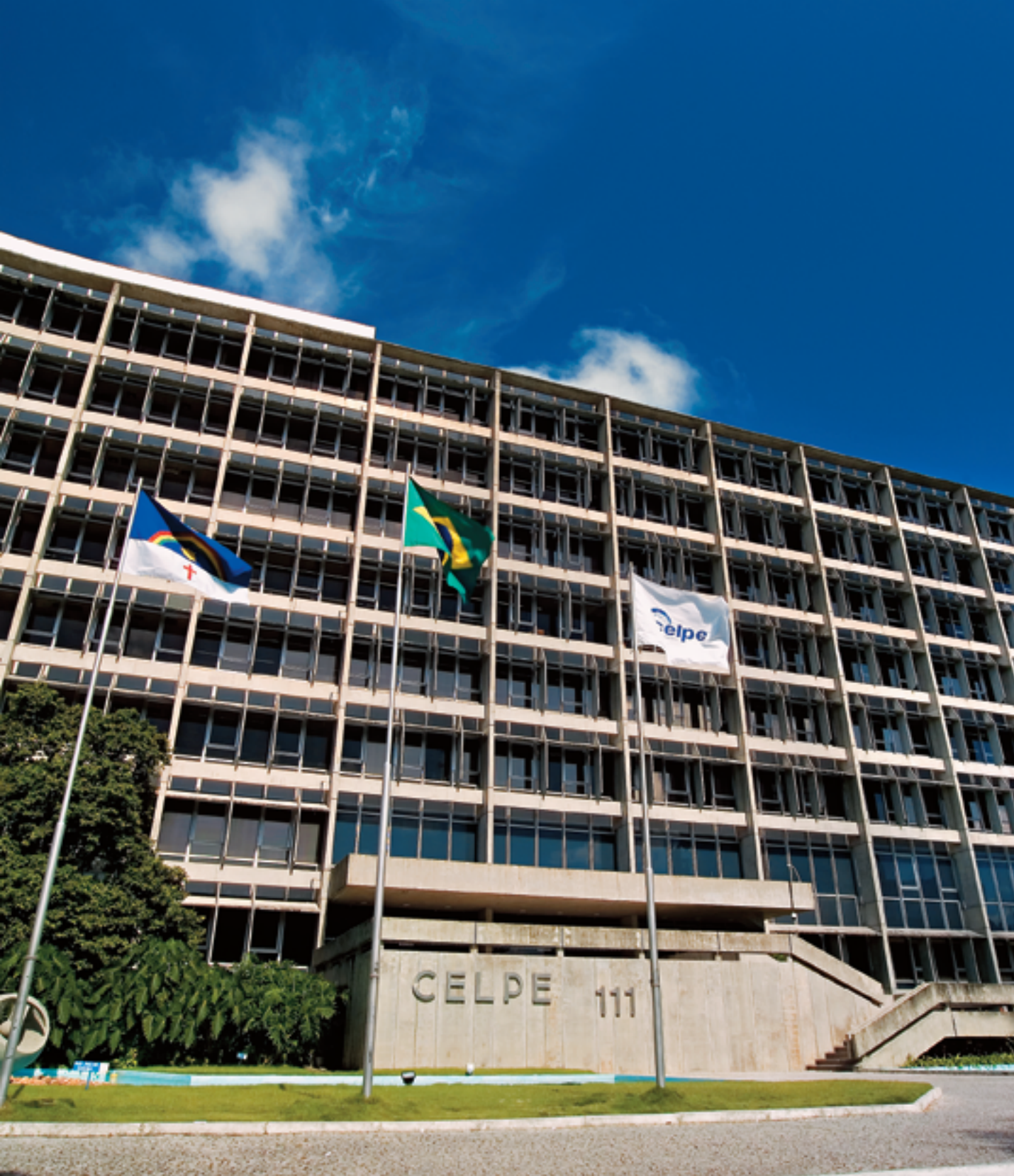
Sede da Celpe, Recife (PE).
