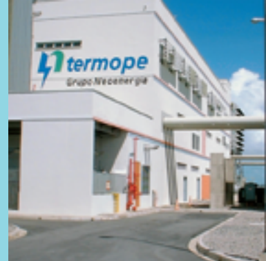
Sede da Termopernambuco (PE).
