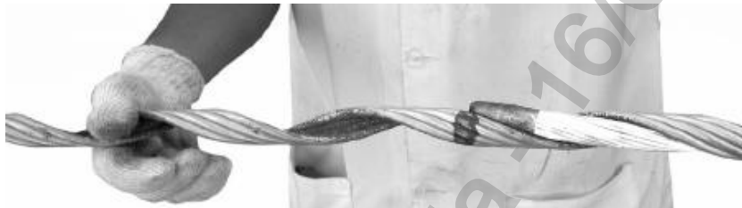
Aplicar metade da emenda no cabo
