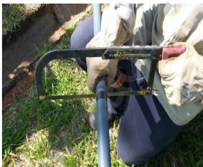
Figura 04 - Corte do tubo de ajuste
