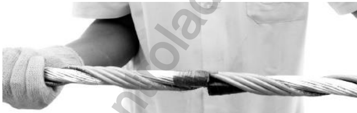
Segunda metade da emenda na outra parte do cabo
