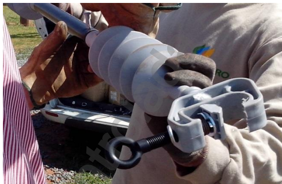
Figura 01 – Instalação do isolador com garra com pino travante
