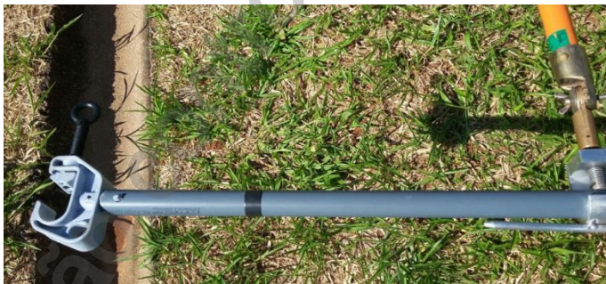
Figura 03- Engate do bastão no espaçador
