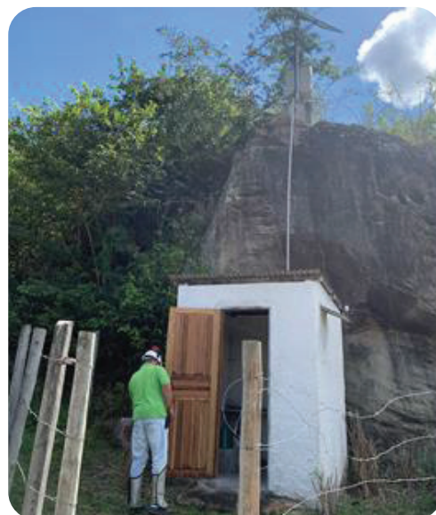
Estação sismográfica ITAP1 – UHE Itapebi. Foto: Consultoria e Tecnologia Ltda.
