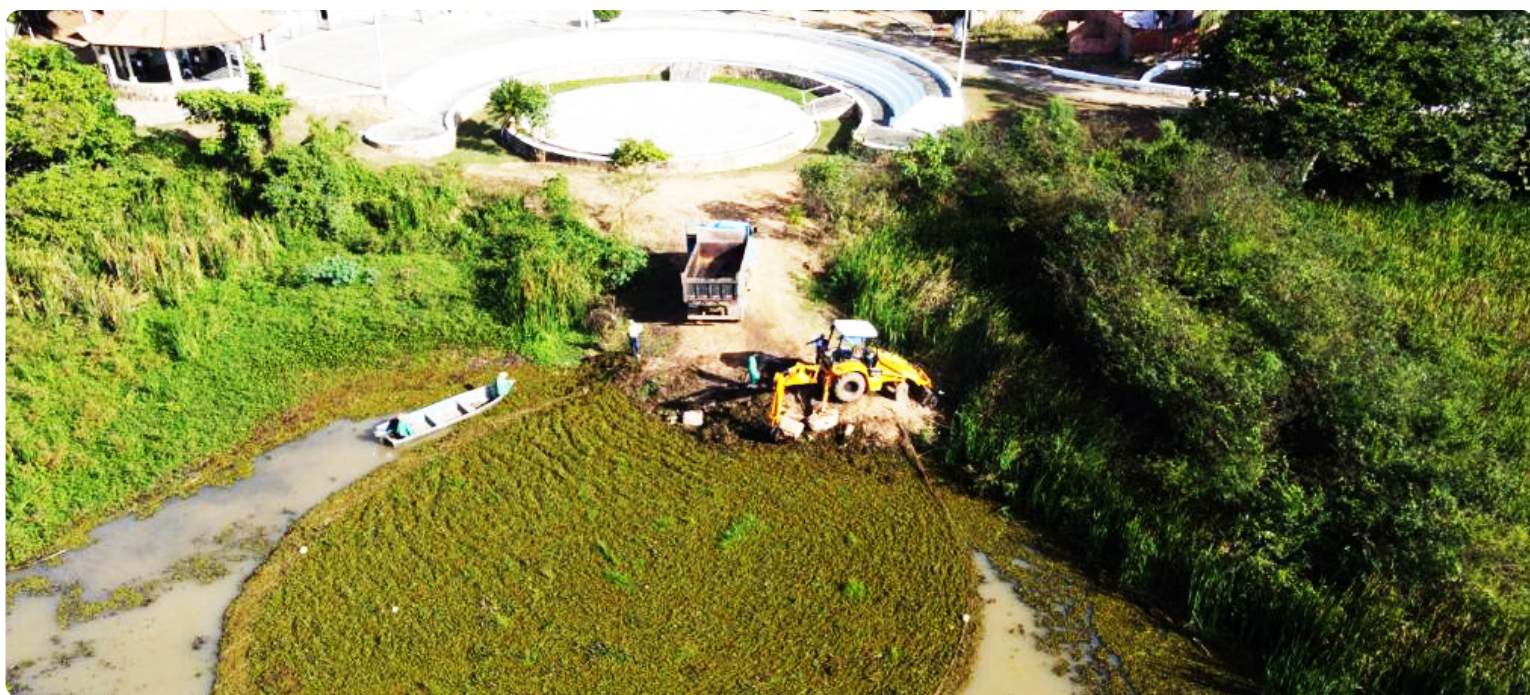
Processo de retirada de macrófitas em Salto da Divisa/MG. Foto: Verdal Tecnologia Ambiental Ltda.
