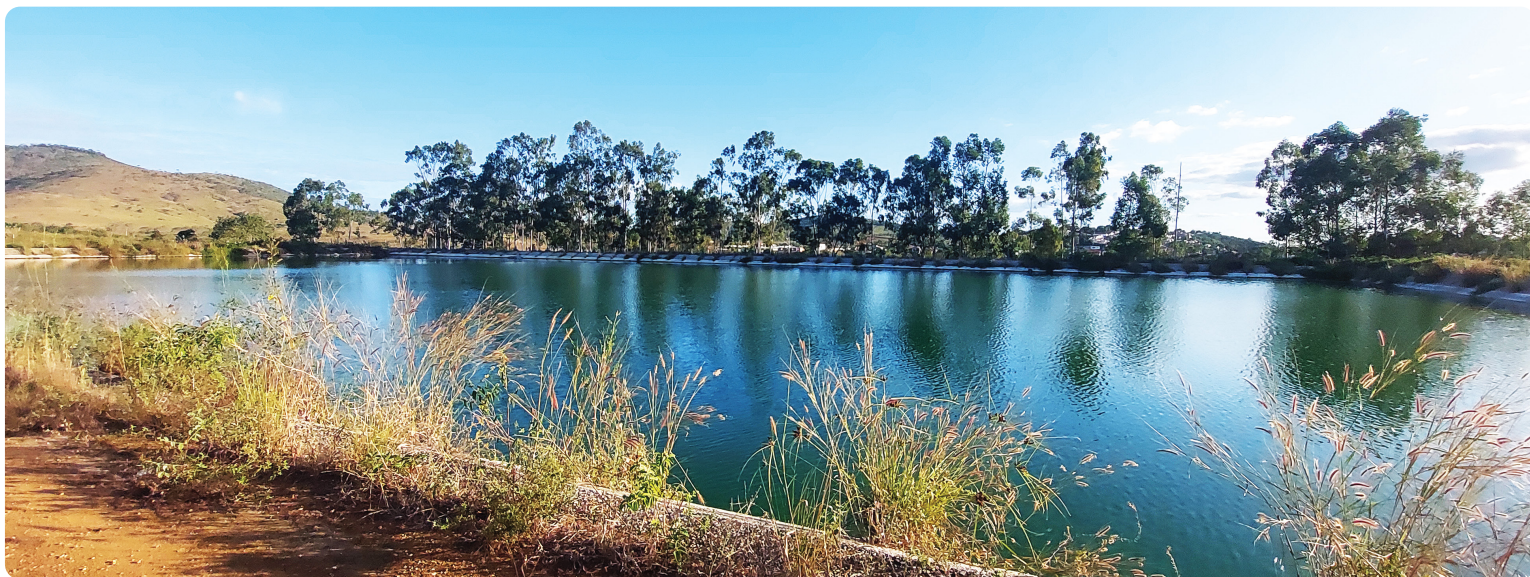
Lagoa de Maturação da ETE – Salto da Divisa/MG
