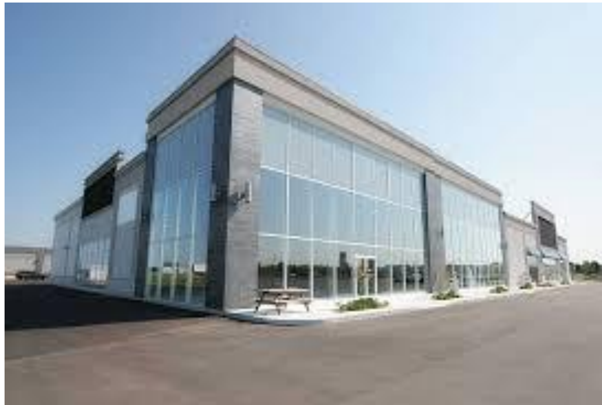
Edificações individuais acima de 75 kVA de demanda
