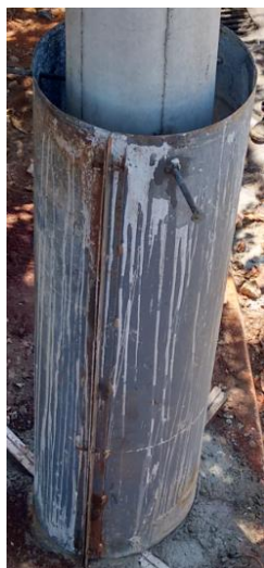
Fotos Ilustrativas – Forma para recuperação de poste
