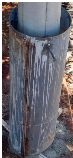
Fotos Ilustrativas – Forma para recuperação de poste
