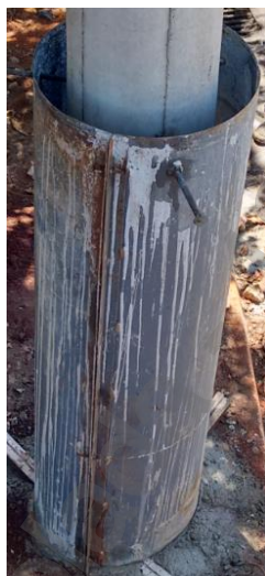
Fotos Ilustrativas – Forma para recuperação de poste
