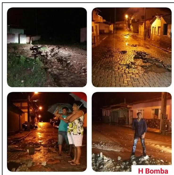
Figura 11 – Danos causados pelas chuvas em Itarantim
