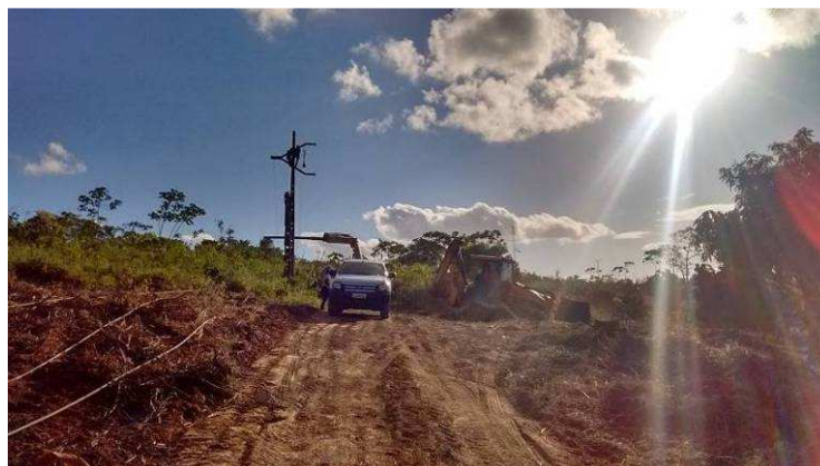
Figura 15 – Abertura para acesso das estruturas
