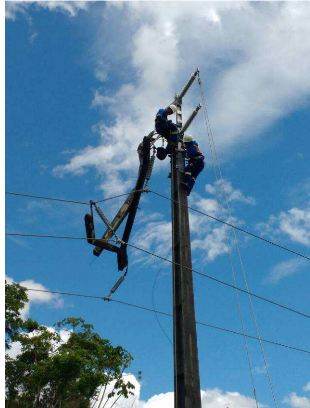
Figura 19 – Estrutura com Cantoneiras e Lines Posts
