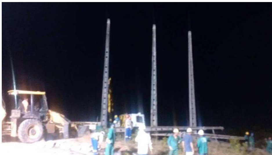
Figura 21 – Implantação dos Postes da Estrutura 68
