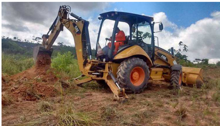
Figura 16 – Abertura da Cava do Poste
