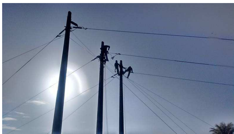
Figura 22 – Passagem dos Cabos na Estrutura 68
