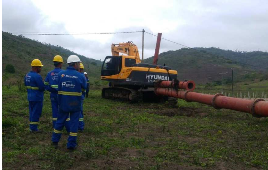
Figuras 16: Semi-Montagem da Estrutura de Emergência no pé do morro
