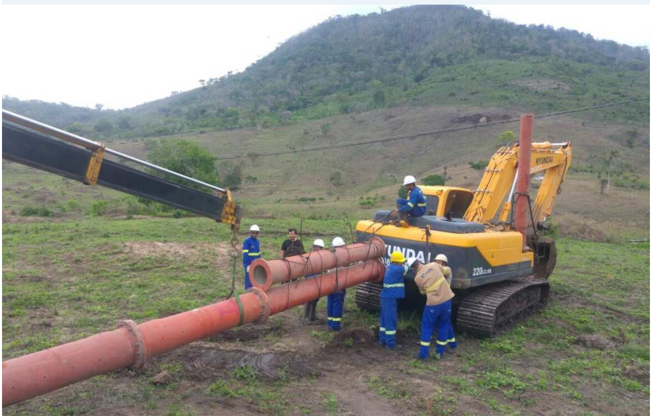
Figura 17: Semi-Montagem da Estrutura de Emergência no pé do morro
