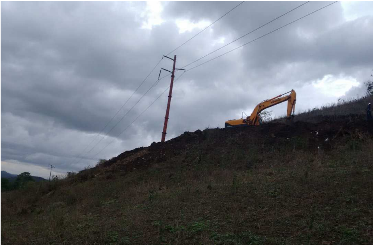
Figura 19: Estrutura final implantada
