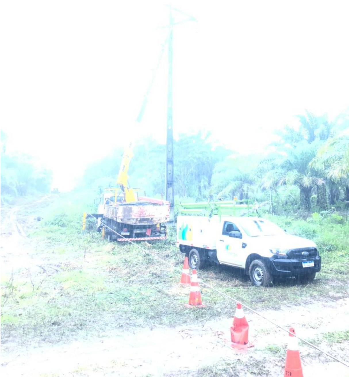
Figura 20 – Equipe em posição para executar o serviço.
