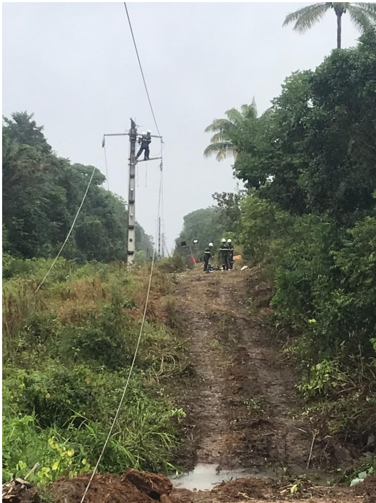
Figura 33 – Equipe executando o trabalho (2).
