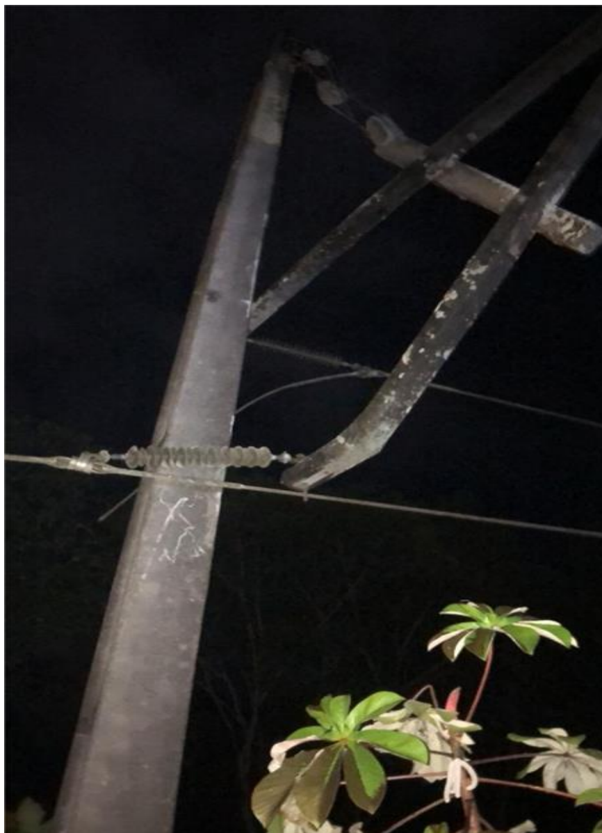
Figura 34 – Estrutura danificada.
