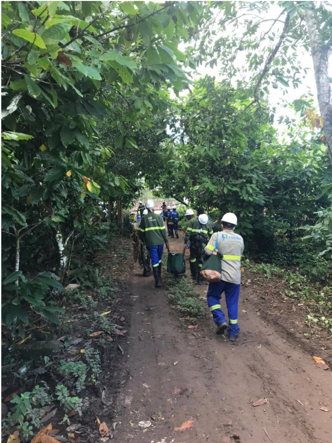
Figura 28 – Equipe seguindo a pé para fazer o reparo.
