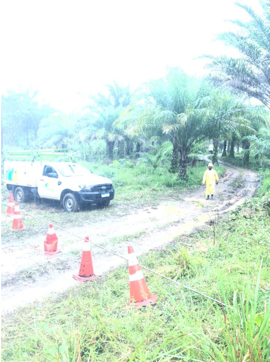
Figura 22 – Equipe tentando executar o trabalho sobre forte chuva (2).
