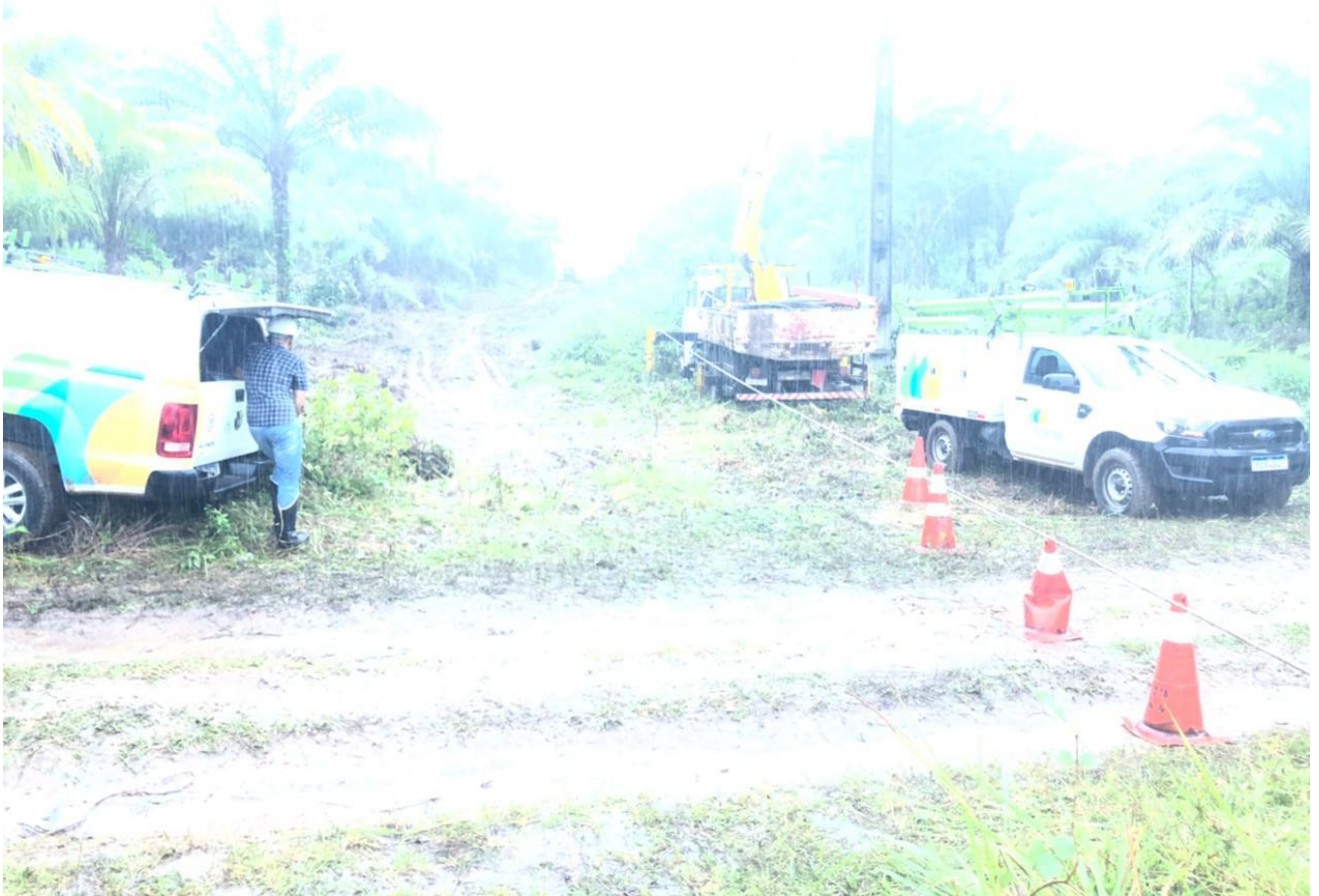
Figura 21 – Equipe tentando executar o trabalho sobre forte chuva.
