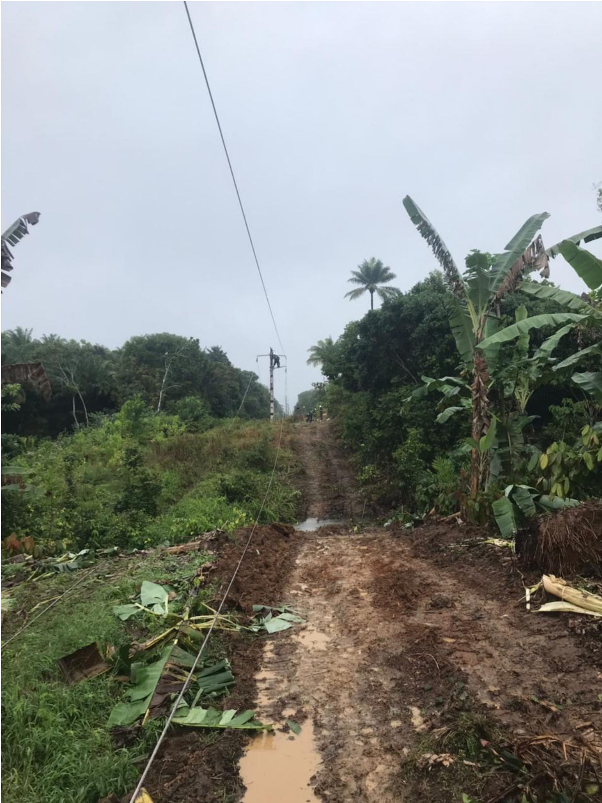
Figura 29 – Equipe executando o trabalho.
