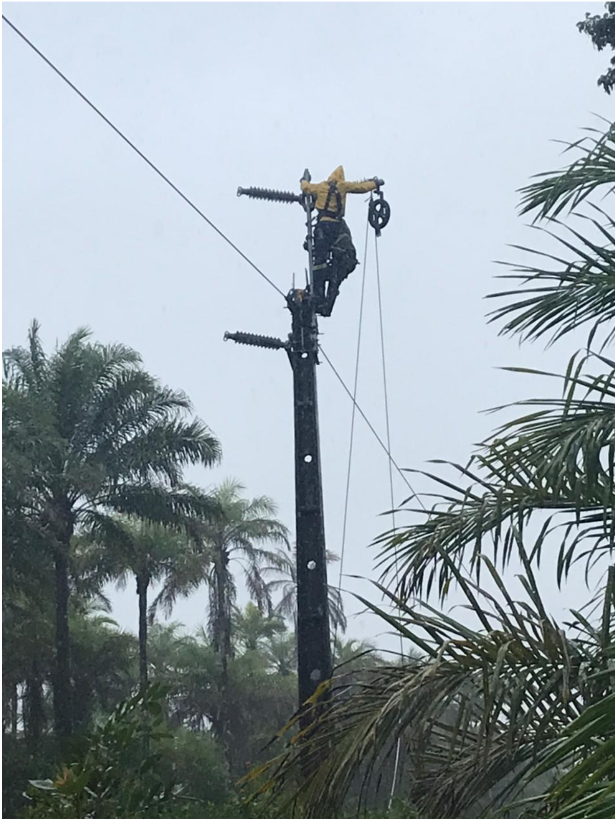
Figura 32 – Equipe executando o trabalho.
