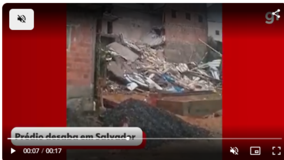
Prédio desaba durante chuva em Salvador
