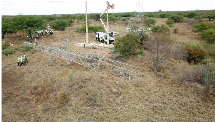
Figura 22 – Atuação da equipe na substituição da estrutura.
