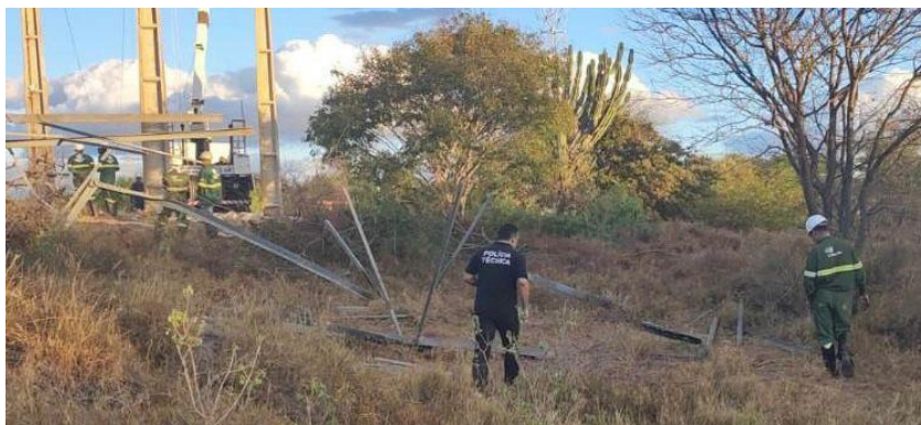
Figura 21 – Registro do poste encontrado no dia do evento.
