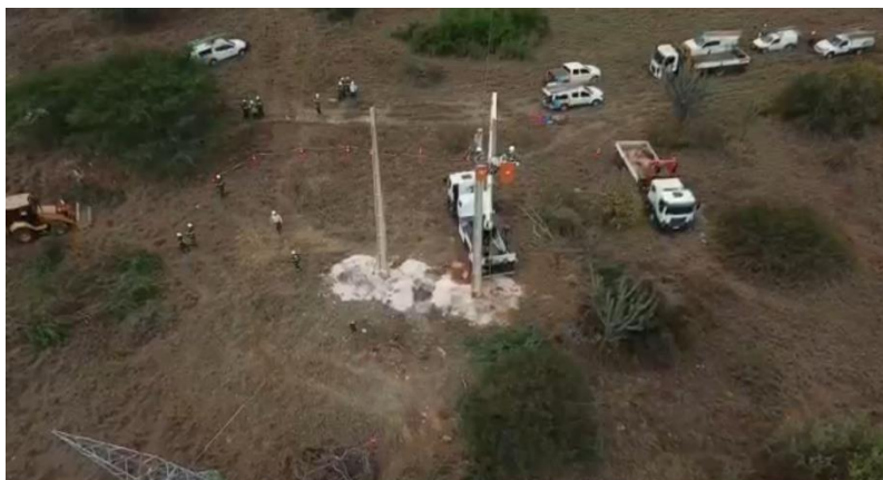
Figura 25 – Atuação da equipe na substituição da estrutura.
