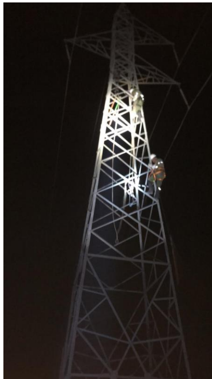
Figura 24 – Atuação da equipe na substituição da estrutura.
