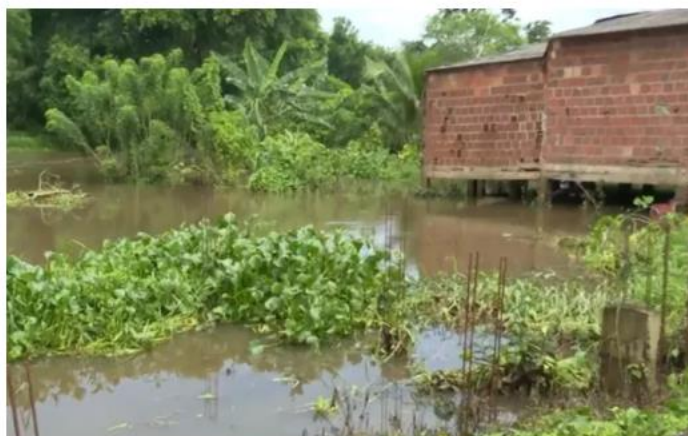
Alagamentos causados pela chuva são registrados em cidades do sul e extremo sul da Bahia — Foto: Reprodução/TV Santa Cruz
