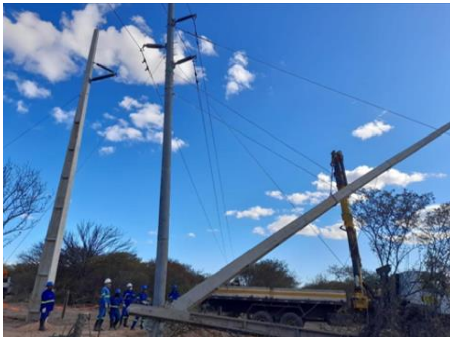
Figura 18 – Atuação da equipe na substituição da estrutura
