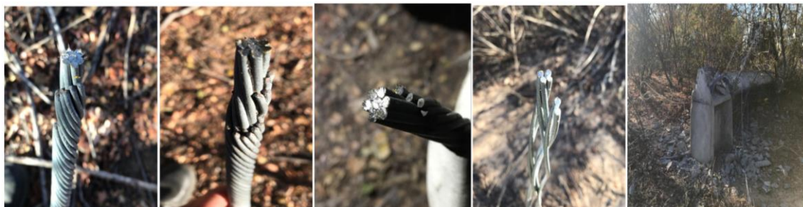
Figura 3 – Imagem das cordoalhas de sustentação da estrutura da LT 02M2 CSB-RMN
