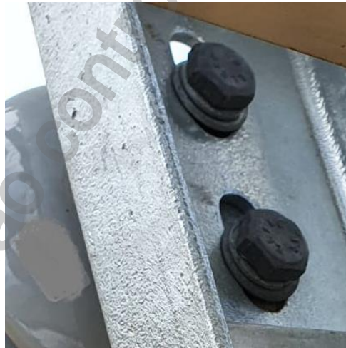
Imagem 4 – Fixação dos Isoladores nas Bases das Seccionadoras tipo By-pass
