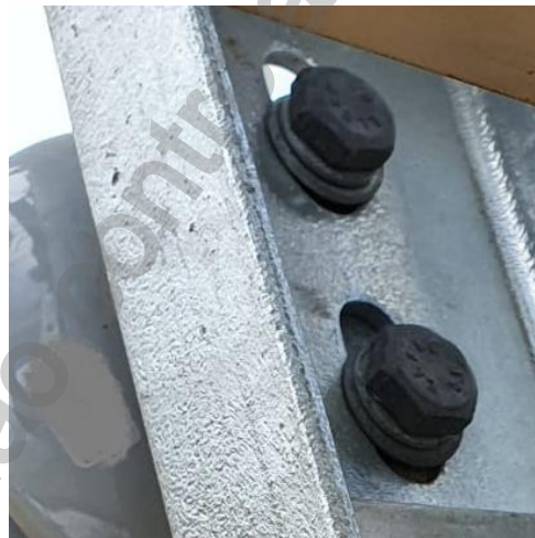
Imagem 3 – Fixação dos Isoladores nas Bases das Seccionadoras tipo By-pass
